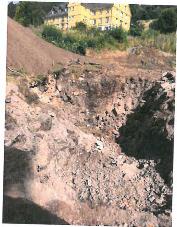
Entfernung von Gebäudefundamenten und Material der ehemaligen Fabrik
