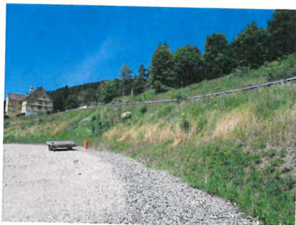
Hang nach Rodung der Gehölze, Blick auf westlich angrenzendes Hotelgebäude
