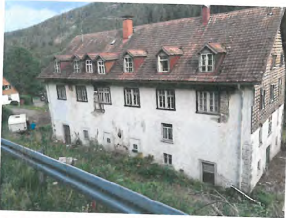
Fabrikgebäude vor dem Abbruch
