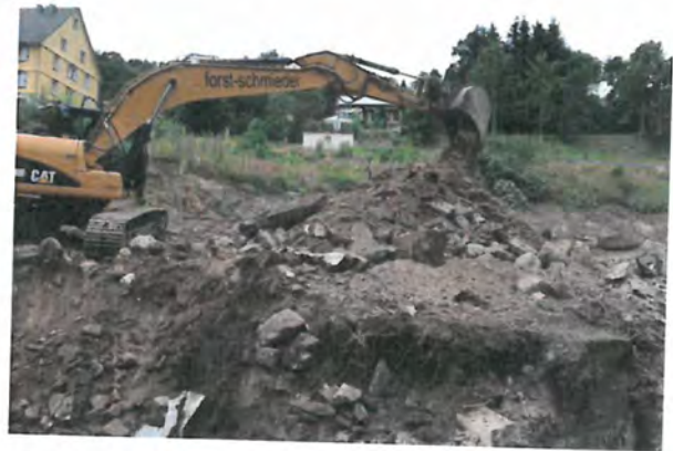
Entfernung von in der Vergangenheit eingebautem Material
