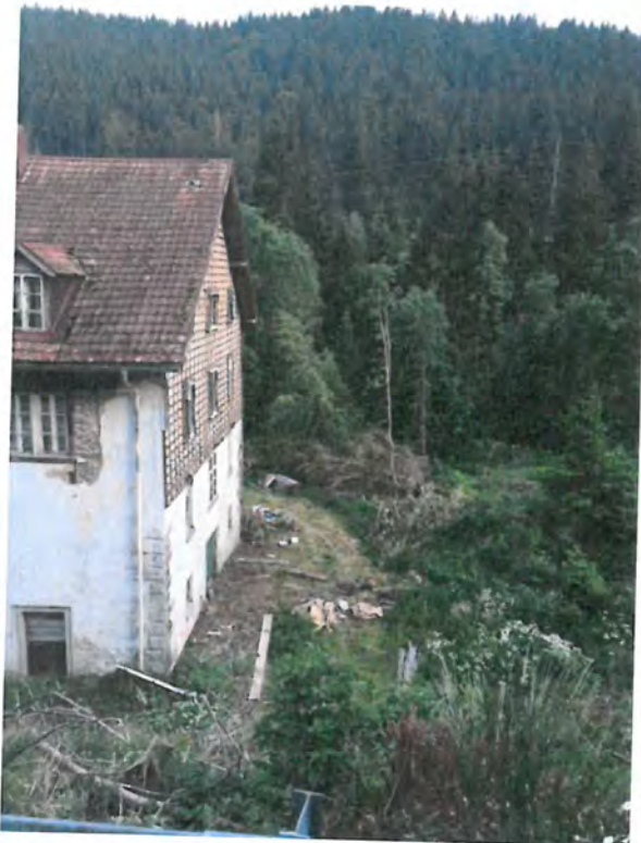
Blick auf die westliche Gebäudeseite
