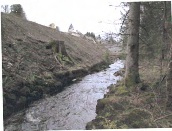
Böschung der Haslach mit Befestigung des Böschungsfußes
