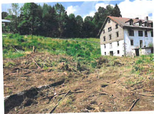
Blick in Richtung Norden auf die bestehende Böschungfläche
