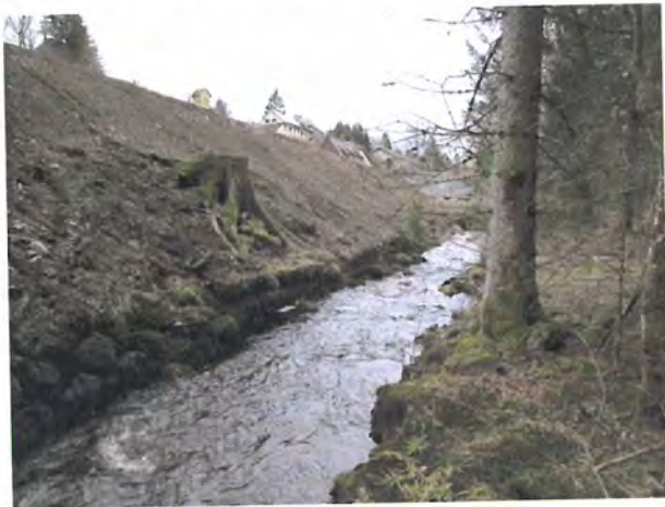
Befestigung des Böschungsfußes (Zustand Oktober 2015)
